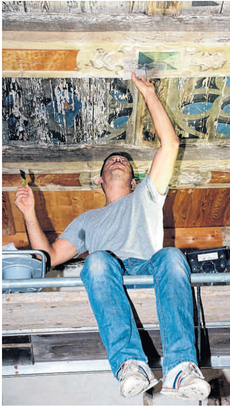
Konzentriert bei der Arbeit: Restaurator Tino Simon bindet von einem Baugerüst aus die losen Farbaufträge wieder an den Untergrund. FOTOS: THOMAS CHRISTEL
